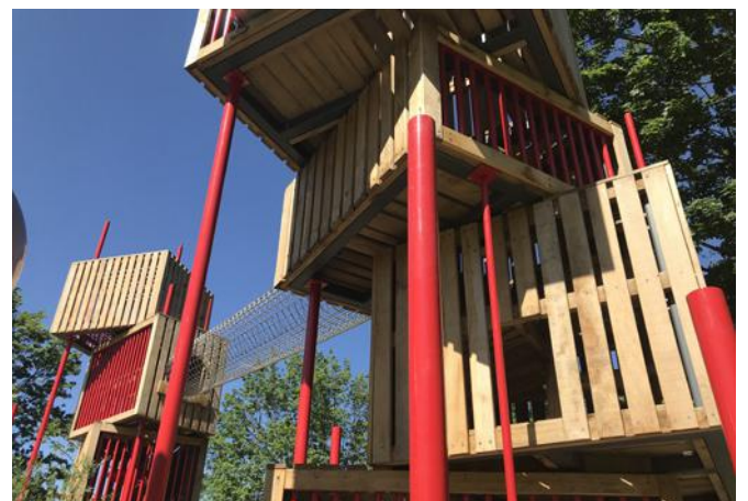
die zwei türme sind mit einem gittertunnel verbunden und erschliessen durch diverse klettermöglichkeiten
